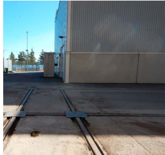
Kuva 2. Loviisan ydinvoimalaitoksen KPA-lastausaseman ulkoaluetta (kuva: Capacent).
