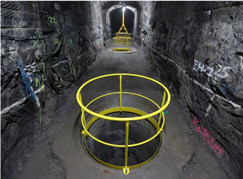
Kuva 8. Posivan loppusijoituslaitoksen demotunnelit ovat tärkeitä loppusijoituksen tutkimus- ja kehitystyössä ennen loppusijoitustoiminnan alkamista. Lähde: Posiva Oy.
