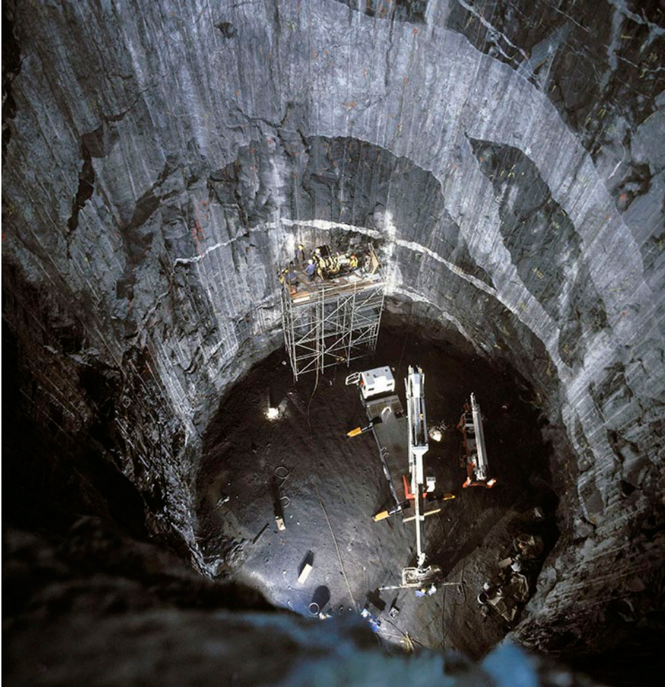
Kuva 7. Olkiluodon ydinvoimalaitoksen käyttö- ja käytöstäpoistojäte loppusijoitetaan laitospaikalla VLJ-luolaan. Lähde: TVO/Korpi-Hallila.
