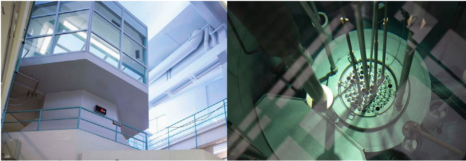
Kuva 9. VTT:n FiR 1-tutkimusreaktori (vasemmalla) ja tutkimusreaktorin reaktoriallas ja reaktorisydän (oikealla) eivät ole enää käytössä. Käytetty ydinpolttoaine on poistettava reaktorista ennen tutkimusreaktorin purkamisen aloittamista. Lähde: VTT
