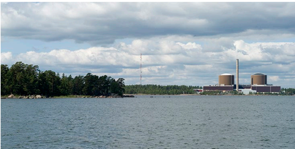
Kuva 2. Loviisan ydinvoimalaitos. Lähde: Fortum Power and Heat Oy
