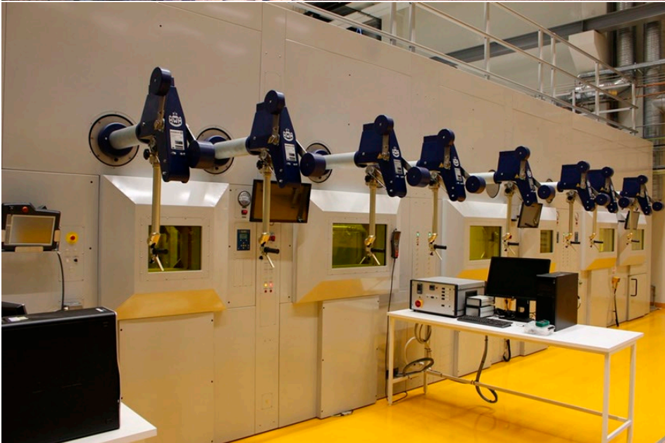
Kuva 11. VTT:n uusi Ydinturvallisuustalo (ylhällä) ja talon kuumakammiot radioaktiivisten materiaalien tutkimukseen (alhaalla) ovat valmiina. Ydinturvallisuustalon jätehuollon suunnittelu on tärkeää ja ajankohtaista. Lähde: VTT
