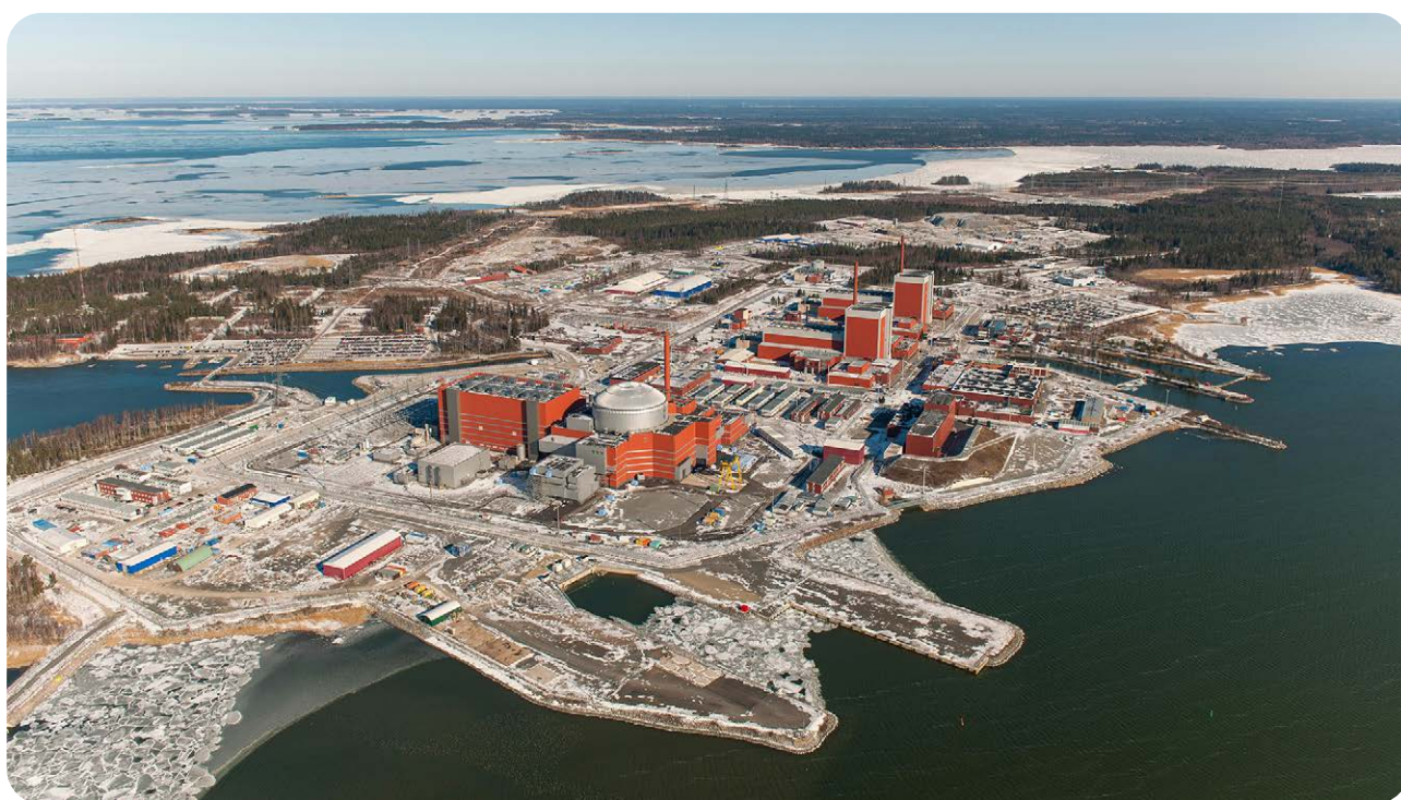
Bild 2. Flygfoto över kraftverksområdet.
