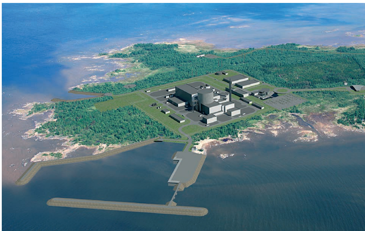
Kuva 6. Ilmakuvavasovite ydinvoimalaitoksesta Hanhikiven niemellä.
