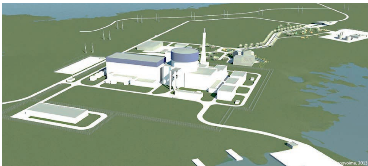
Kuva 3-3. Rosatomin AES-2006 painevesireaktori.
