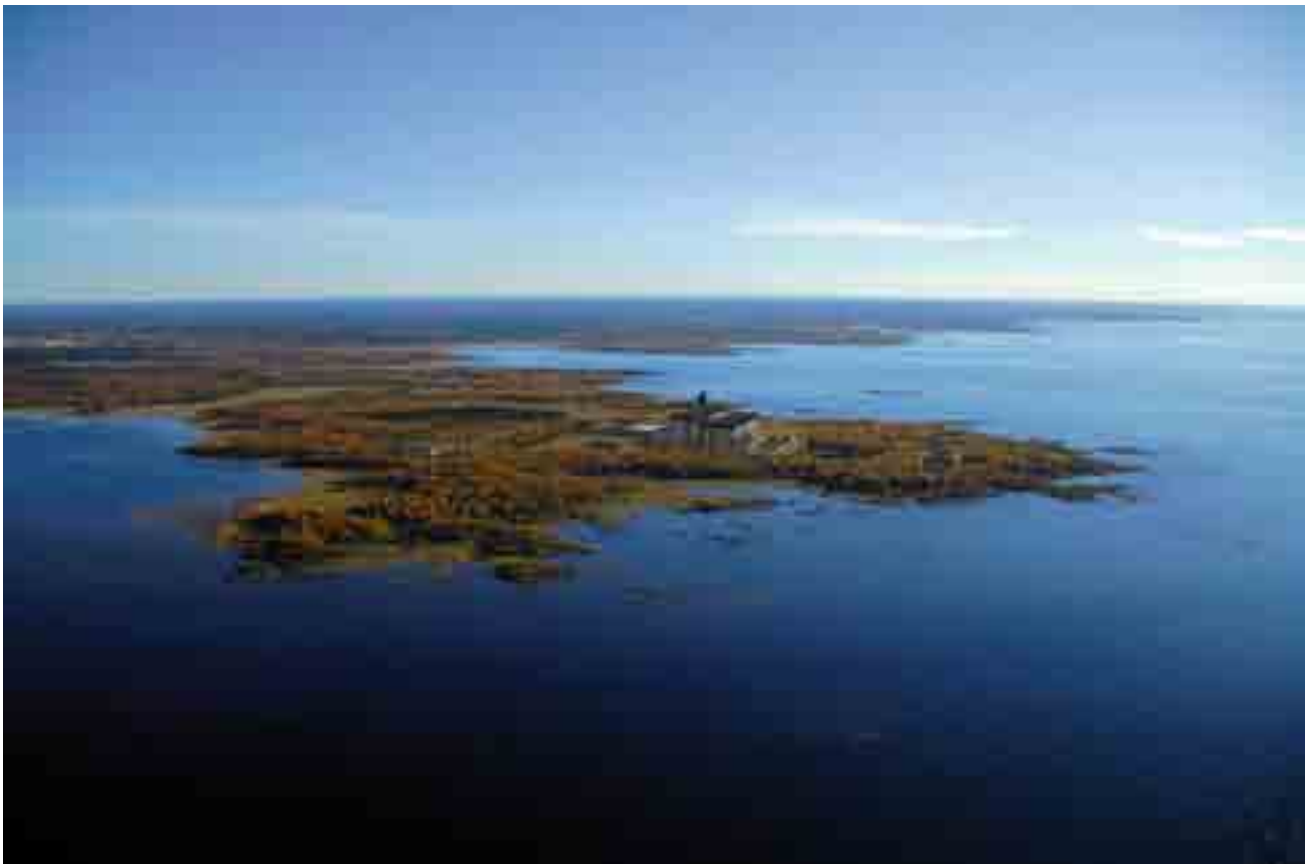
Kuva 8-56. Kuvasovite: Ydinvoimalaitos Hanhikiven niemellä. Kuvassa on kaksi voimalaitosyksikköä. Kuva yhden voimalaitosyksikön vaihtoehtosta esitetään sijaintipaikkavaihtoehtoja koskevassa luvussa 1.4.1.
