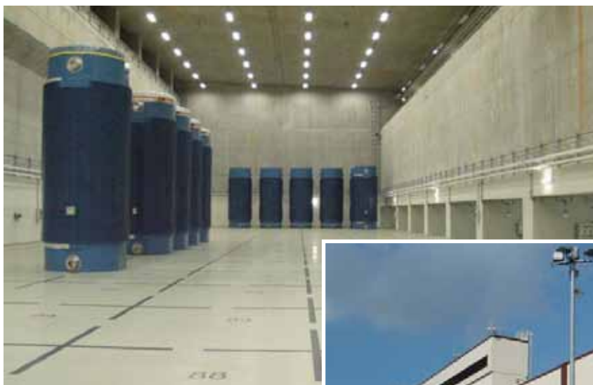
Kuva 3-14 Käytetyn polttoaineen kuiva-varastointitila (E.ON 2008).
