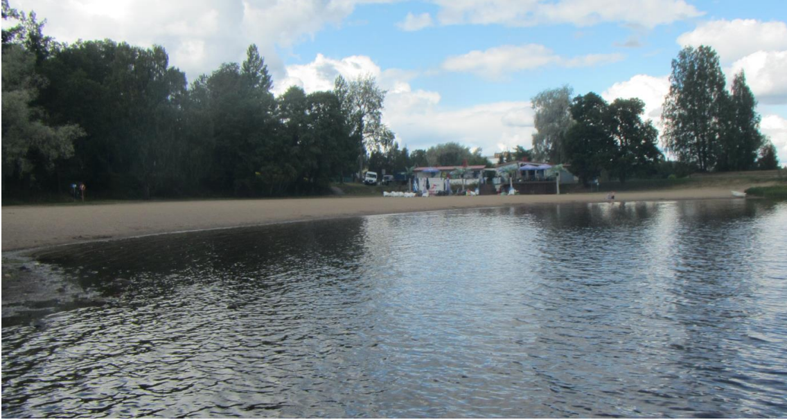
Kuva 3-30. Väinölänniemen läpi kulkeva putkilinja menee läheltä Väinölänniemen uimarantaa.
