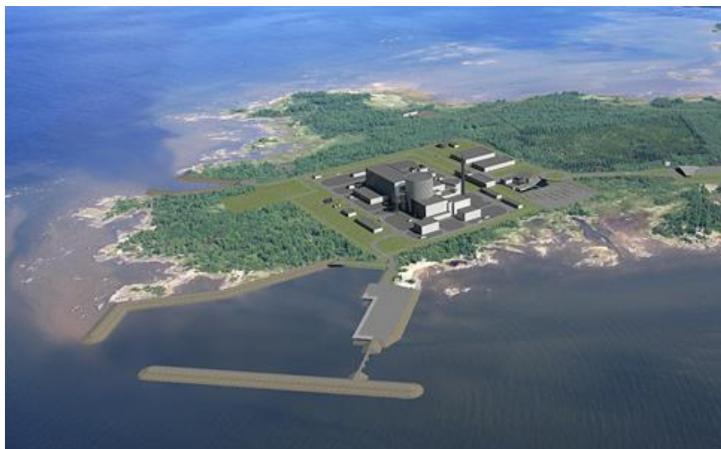
6. attēls. Modificēts skats no augšas uz atomelektrostaciju Hanhikivi pussalā.
