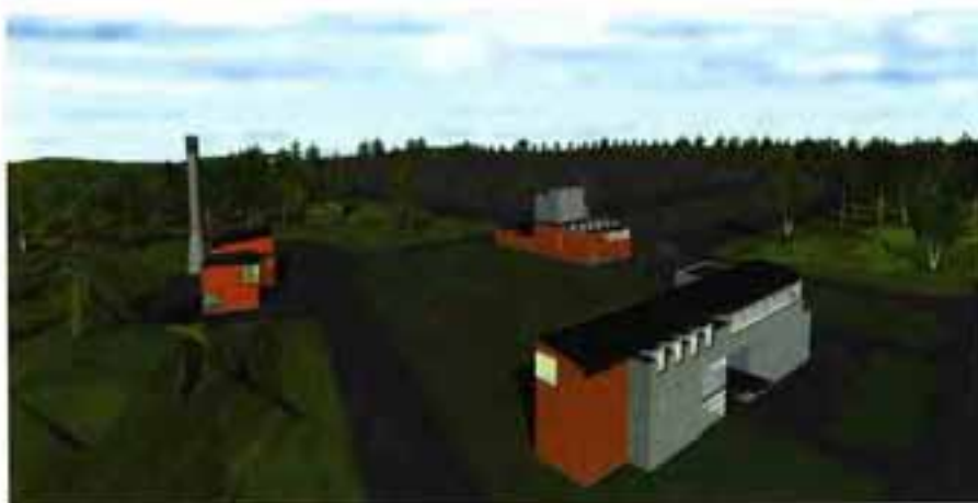
Fig. 4-4. Exempel på byggnader ovanför arbetsschaktet och i anslutning till det. I förgrunden en kontorsbyggnad med forskningsrum, till höger byggnaden ovanför arbetsschaktet och till vänster en värme- och vattenanläggning. I bakgrunden en upplagsplats för sprängsten och bergkross.
