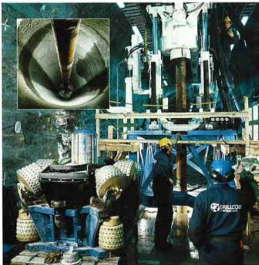
Fig. 4-18. Kapselhålen kan fullortsborras. Fotografiet är från ett borrarbete i forskningstunneln i Olkiluoto.
