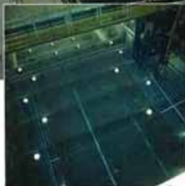
Fig. 2-4. Vattenbassänglager för använt kärnbränsle i Olkiluoto i Euraåminne. På den mindre bilden ses vattentäckta bränsleelement fotograferade ovanifrån.
