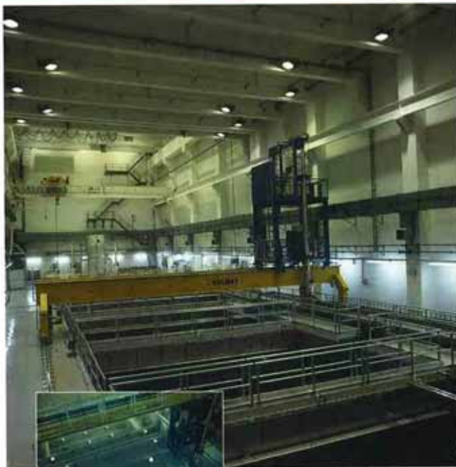
Fig. 2-4. Vattenbassänglager för använt kärnbränsle i Olkiluoto i Euraåminne. På den mindre bilden ses vattentäckta bränsleelement fotograferade ovanifrån.
