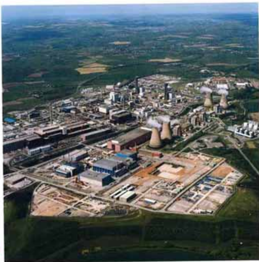
Fig. 2-5. I England upparbetas största delen av det använda kärnbränslet. Bilden visar Sellafields upparbetningsanläggning med omgivning.
