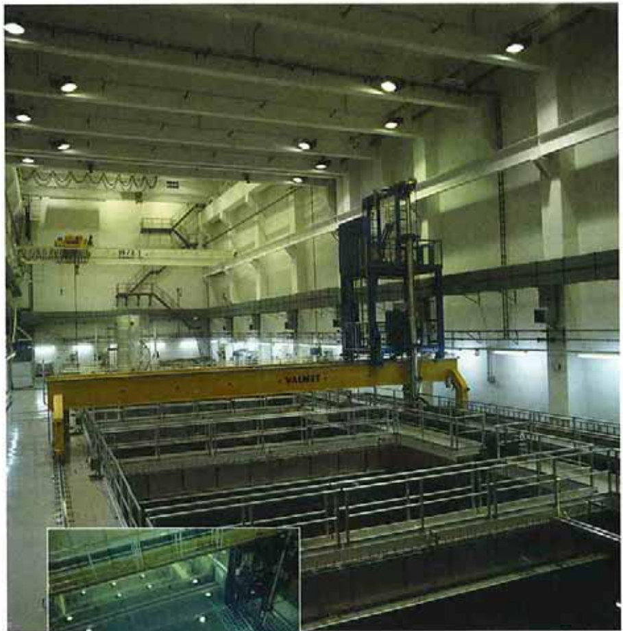
Kuva 2-4. Käytetyn ydinpolttoaineen vesiallasvarasto Eurajoen Olkiluodossa. Pikkukuvassa näkyy veden peittämiä nippuja ylhäältä päin kuvattuna.
