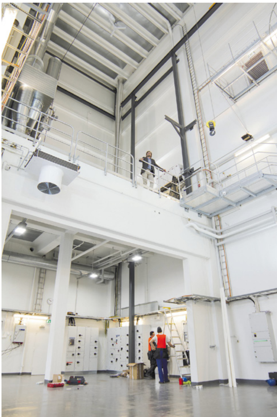
Kuva 5.17. Lappeenrannan teknillisen yliopiston uusi ydinvoimalaitosten kokeellisen lämpö- ja virtaustekniikan tutkimuslaboratorio. (Kuva: Timo Mikkola)
