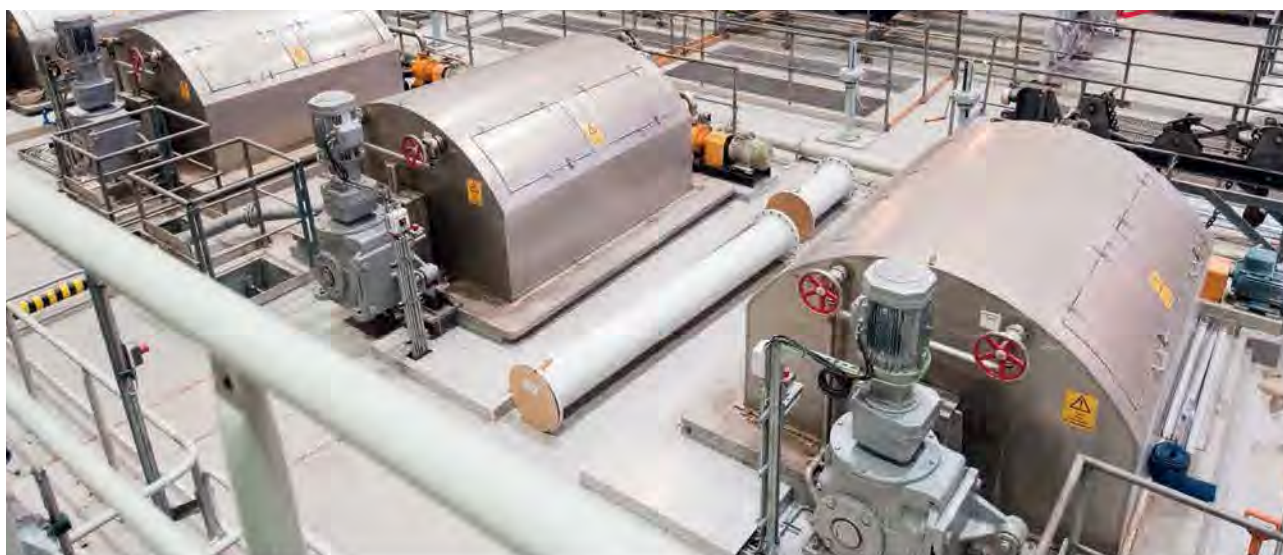
Väppä- ja pumppurakennus
