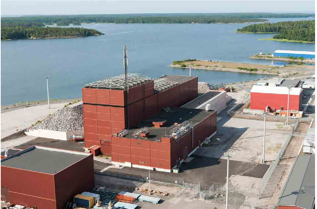
Kuva 11. Käytetyn polttoaineen välivarasto (KPA-varasto) sijaitsee laitosalueella ja siellä käytetty ydinpolttoaine jäähtyy, kunnes se loppusijoitetaan Posivan Olkiluodossa sijaitsevaan loppusijoituslaitokseen.
