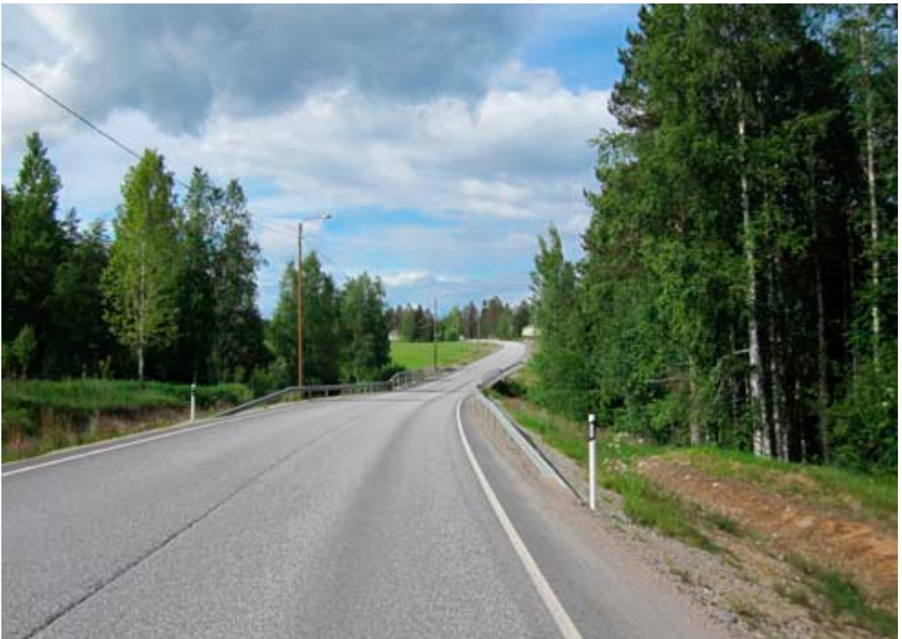
■ Kuva 8-4. Tieyhteys kaivosalueelta Tuhkakylän läpi (tie 870)
