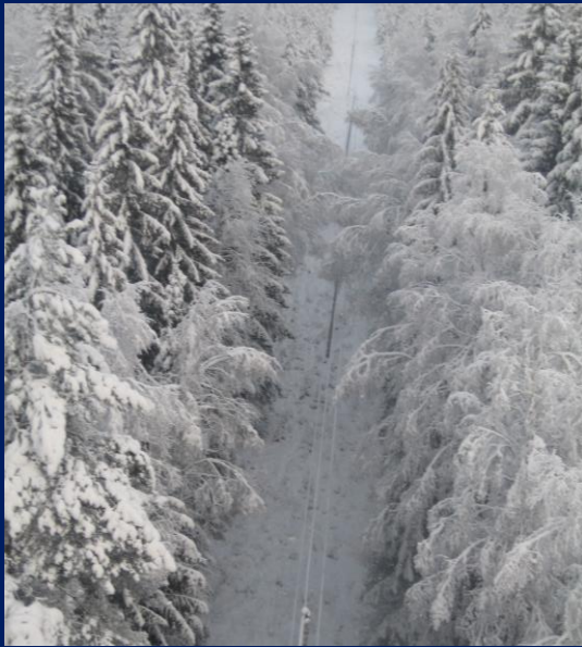
Kuvan lähde: PKS sähkönsiirto Oy, tykkylumiongelmaa v. 2007
