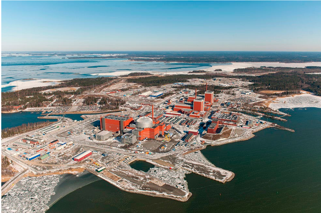
Kuva 3. Teollisuuden Voima Oyj:n ydinvoimalaitosalue Eurajoen Olkiluodossa. Kuva: Teollisuuden Voima Oyj.
