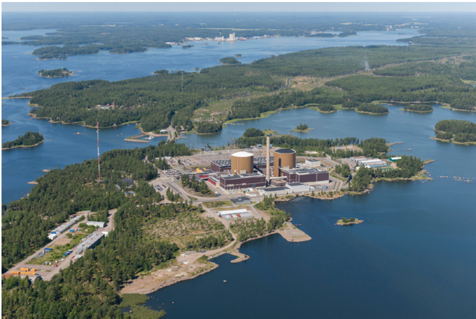
Bild 1-4. Flygbild på kraftverksområdet i Lovisa.
